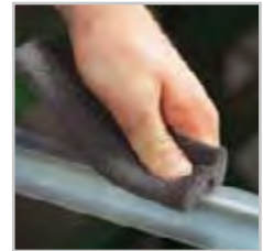
Fijn opschuren met schuurvlies
