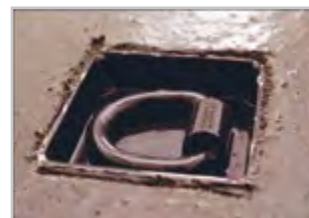
Optioneel: Installatie met sjoorog
